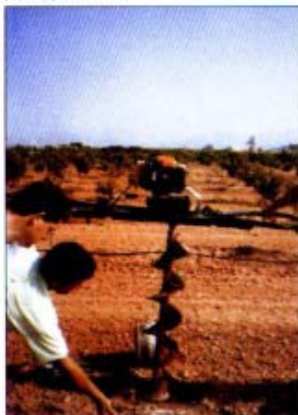
Realización mecánica de cimientos para postes y tensores.
