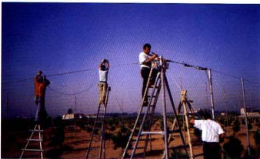
Anudado y tensado de cables.
